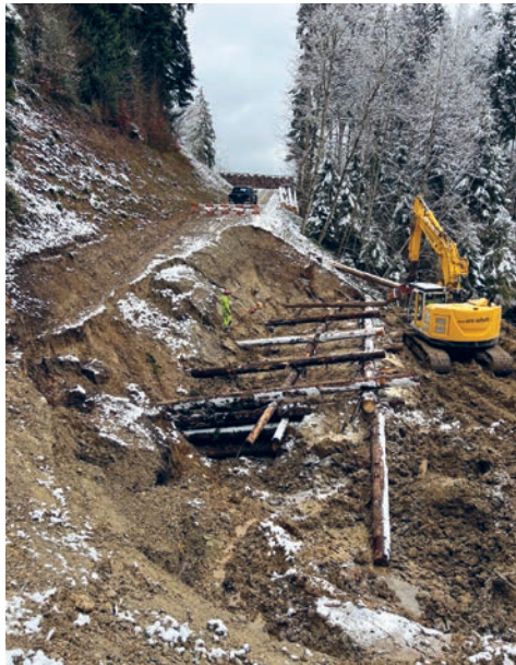
Abb. 3: Sanierung Hangrutsch Buchholz-Egg
